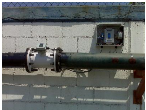
Figura 8. Estación de aforo de un DH con medidor de caudal fijo.
